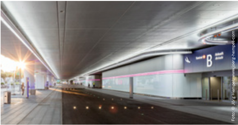
Frankfurt Airport Terminal 1, Deutschland
