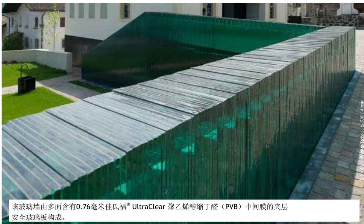
该玻璃墙由多面含有0.76毫米佳氏福® UltraClear 聚乙烯醇缩丁醛（PVB）中间膜的夹层安全玻璃板构成。
