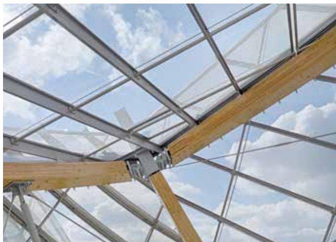
Podría afirmarse que la Fundación Louis Vuitton hace despliegue de uno de las cubiertas más fascinantes jamás vistas.
