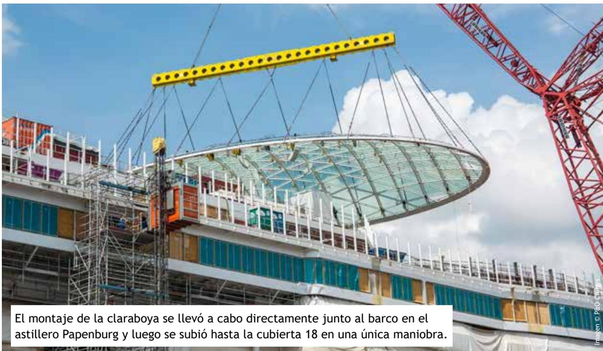
El montaje de la claraboya se llevó a cabo directamente junto al barco en el astillero Papenburg y luego se subió hasta la cubierta 18 en una única maniobra.
