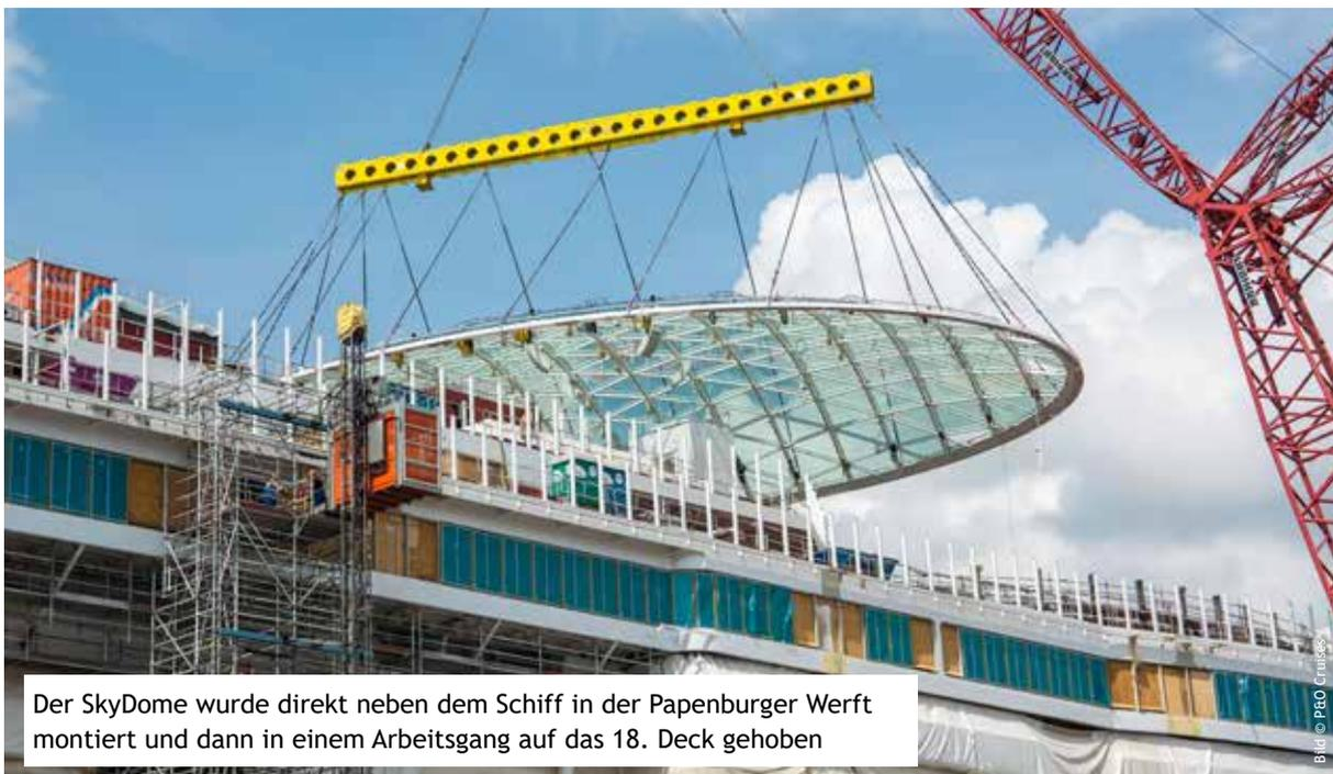
Der SkyDome wurde direkt neben dem Schiff in der Papenburger Werft montiert und dann in einem Arbeitsgang auf das 18. Deck gehoben
