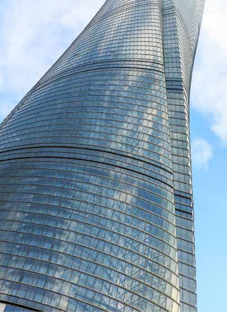
*La forma de la Torre de Shanghái es el resultado de apilar nueve edificios cilíndricos uno encima de otro, todos ellos envueltos por la capa interna de la fachada de vidrio, que completa un giro de 120 grados a medida que se eleva del suelo. El diseño reduce las cargas por viento soportadas por el edificio un 24%.*
