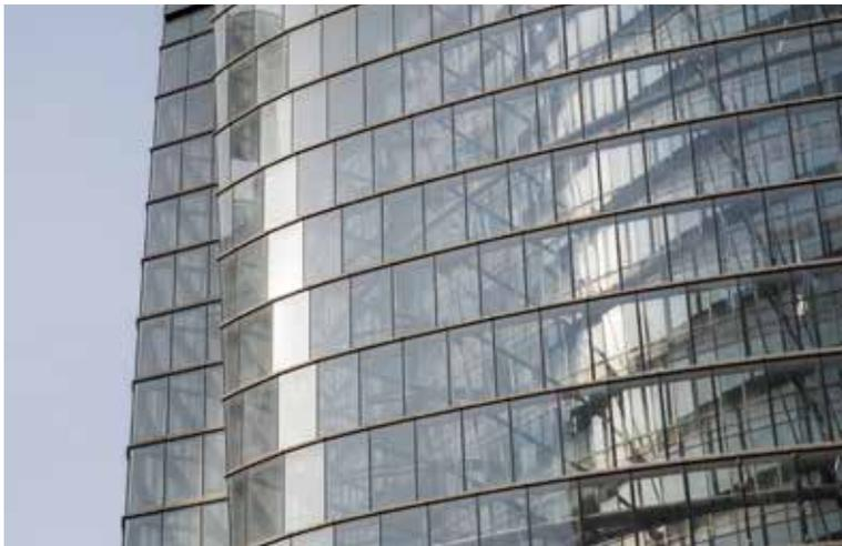
*As principais razões para a escolha do SentryGlas® como interlayer foram: a maior resistência que o material oferece para a estrutura de vidro como um todo; e a eliminação de quaisquer delaminações das bordas, que ficam expostas no envidraçamento estrutural com silicone.*
