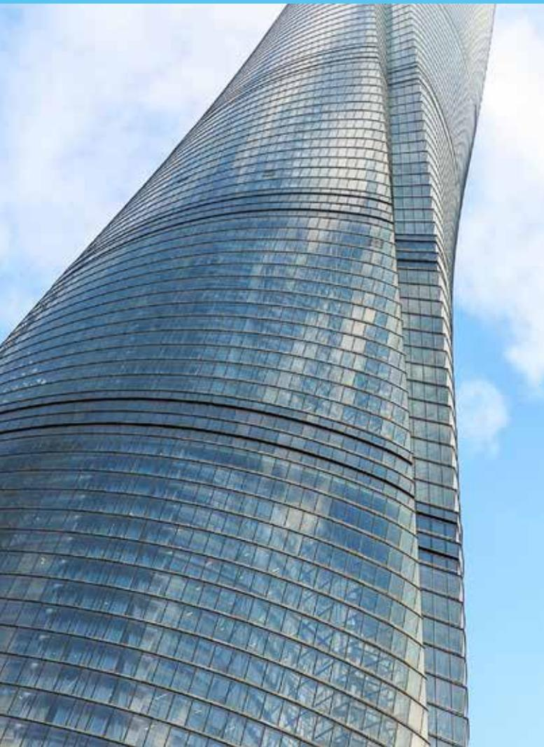
*A Torre Xangai é formada por nove blocos cilíndricos organizados um no topo do outro, todos fechados pela camada interna da fachada de vidro, completando uma rotação de 120 graus à medida que se aproxima do topo. Esta forma reduz a sobrecarga de vento no edifício em 24%.*
