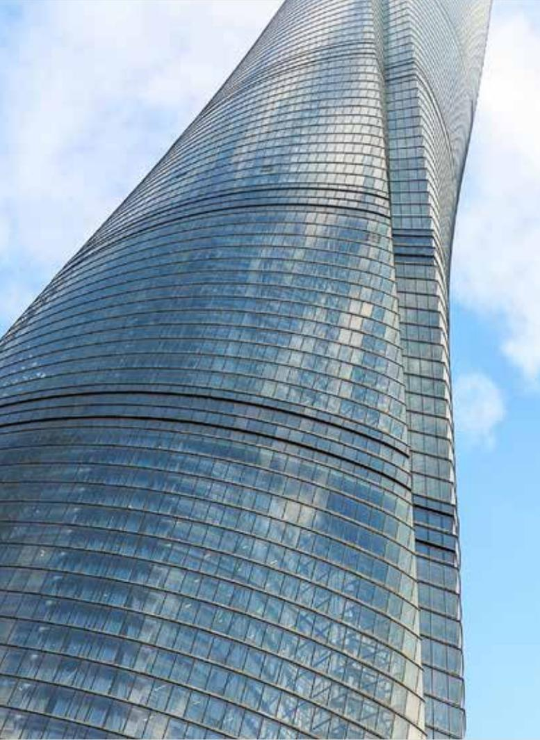
*Der Shanghai Tower besteht aus neun aufeinanderstapelten zylindrischen Elementen, die alle von der inneren Glashülle umschlossen sind, während sich die äußere Hülle von unten nach oben um 120° verdreht. Diese Ausführung reduziert die auf das Gebäude wirkenden Windlasten um 24 %.*
