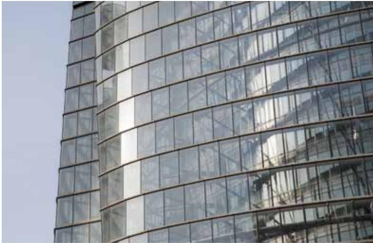
Die Hauptgründe für die Wahl von SentryGlas® als Zwischenlage waren die verbesserten mechanischen Eigenschaften des damit hergestellten Verbunds und die Vermeidung von Delaminationen an offenen Kanten der mit Silikon-Dichtmasse ausgeführten Verglasung.
