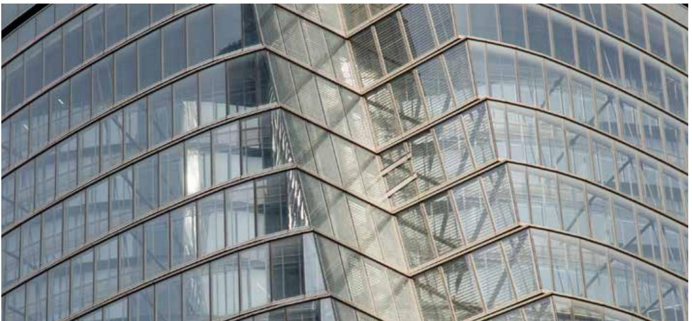
*Für die doppelwandige Glasfassade kamen über 200.000 m<sup>2</sup> SentryGlas® Zwischenlage zum Einsatz.*
