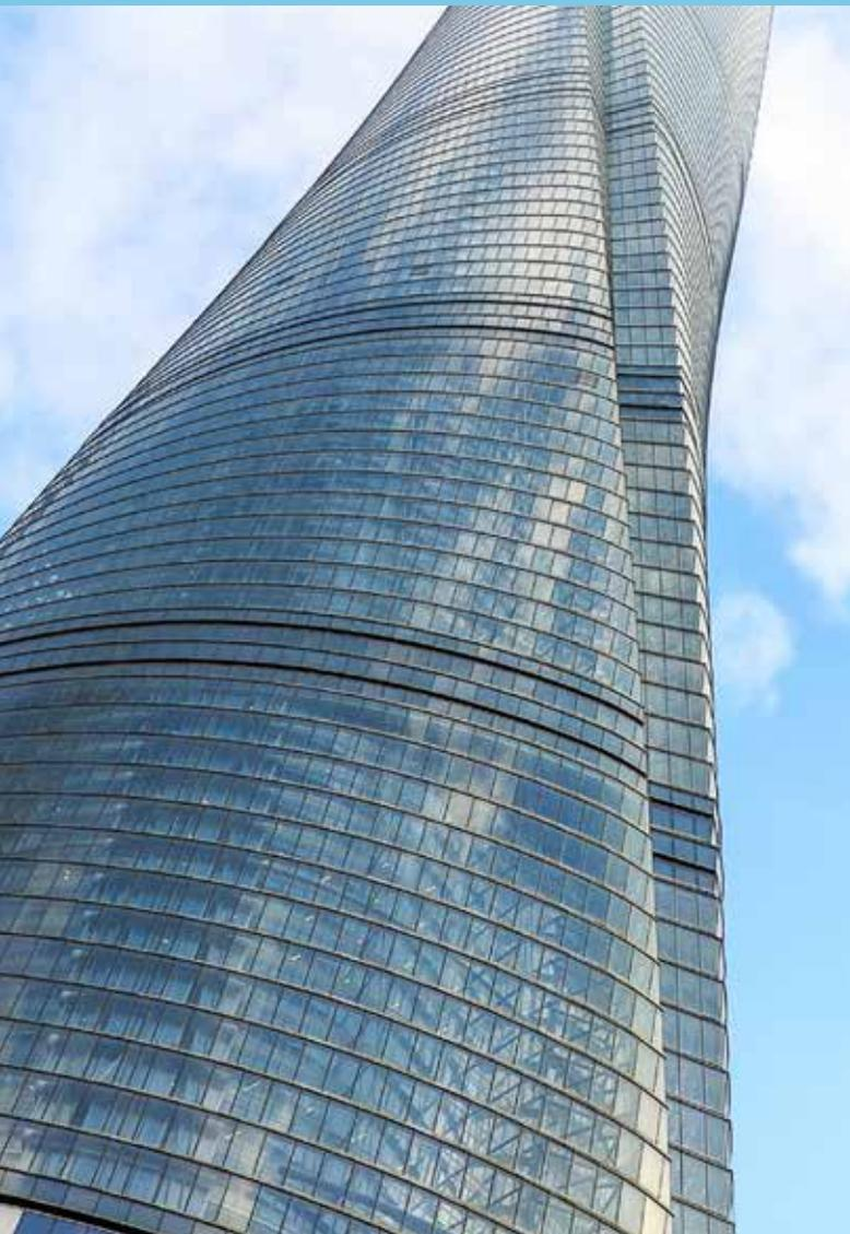
上海タワーは9つの円筒形の建物が積み重なった形をしており、そのいずれもがガラスファサードの内側のガラスで包まれています。ファサードは上に行くに従って120度の角度でねじれていきます。この設計により、ビルの風荷重が24%削減されます。
