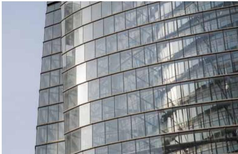
セントリグラス®中間膜が選ばれた主な理由は、ガラスアセンブリ全体に卓越した強度が生まれることと、ストラクチャル・シリコン・グレーディング構法で施工されたファサードのガラスの小口が露出しているにもかかわらず、層間剥離を起こさないことでした。
