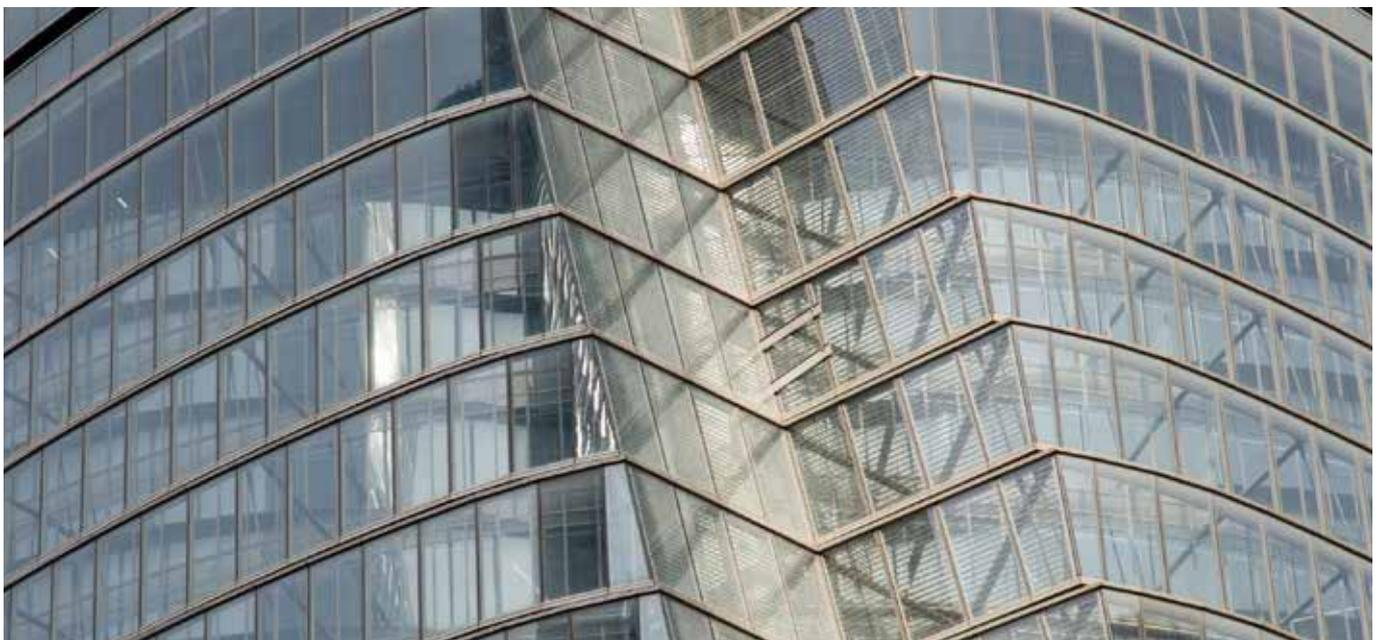
ダブルスキン・ガラスファサードには、20万m<sup>2</sup>以上のセントリグラス® 中間膜が使用されています。
