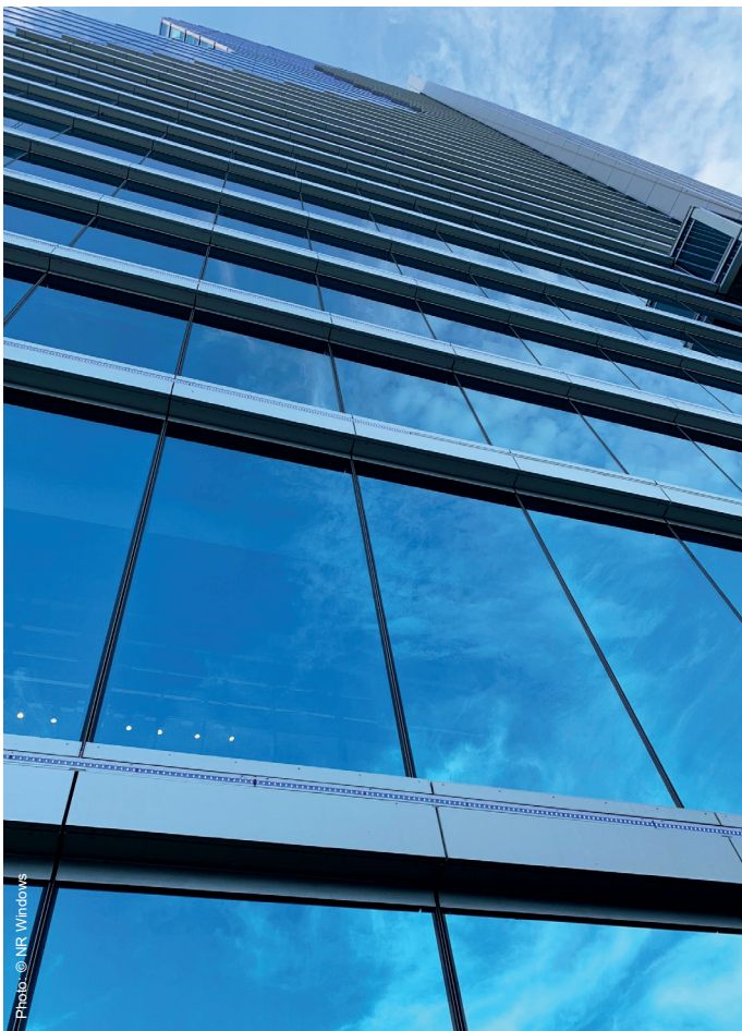
● 호텔의 전체 외관은 SentryGlas® ionoplast(아이아노플라스트) 중간막을 통합한 IGU로 구성되어 있다.
