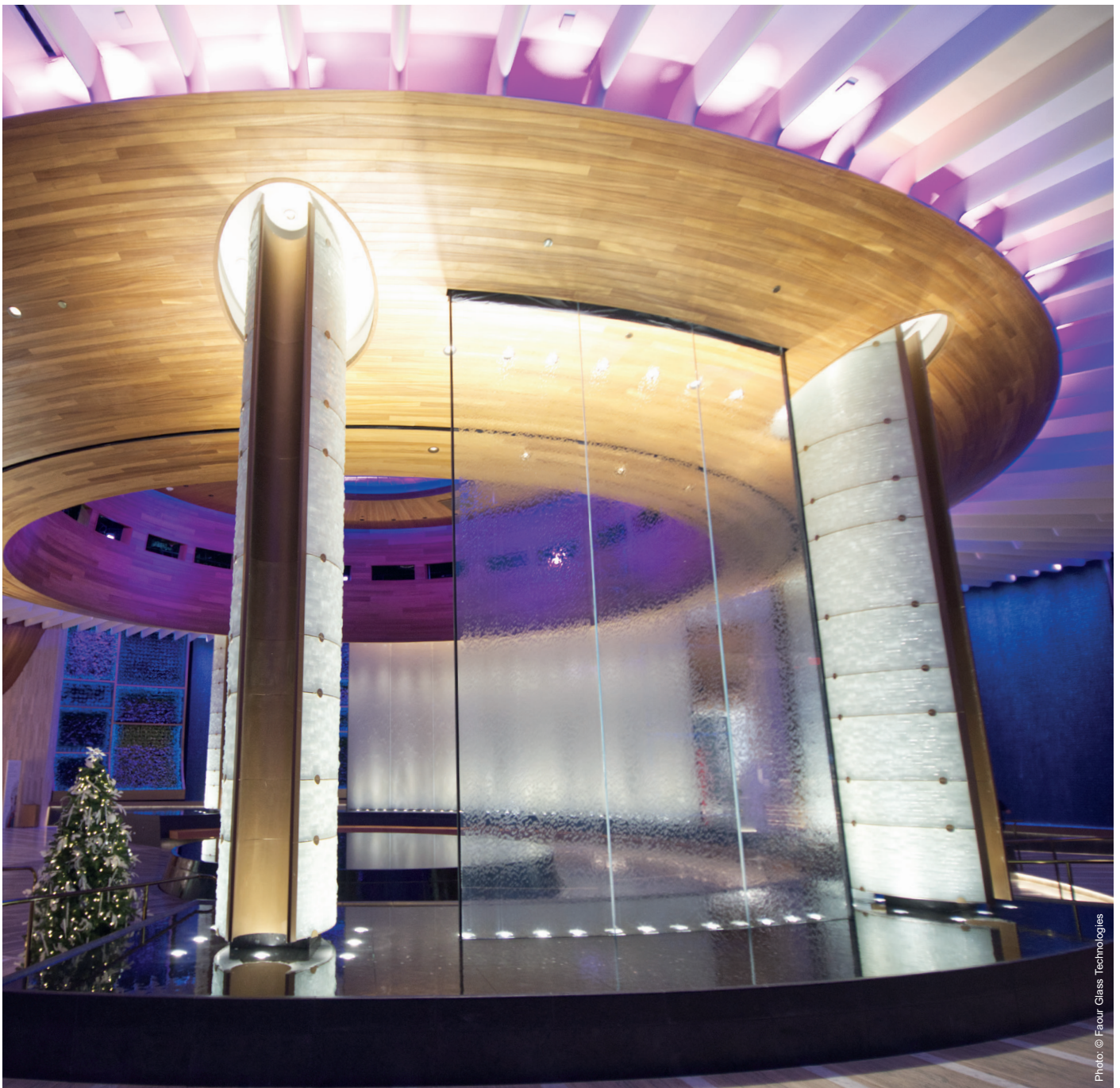
● 직경 12.2m의 유리 실린더 기반의 오클러스는 14개의 맞춤형 접합유리 패널로 구성되어 있으며, 일부에는 프로젝션 필름이 적용되었다.
