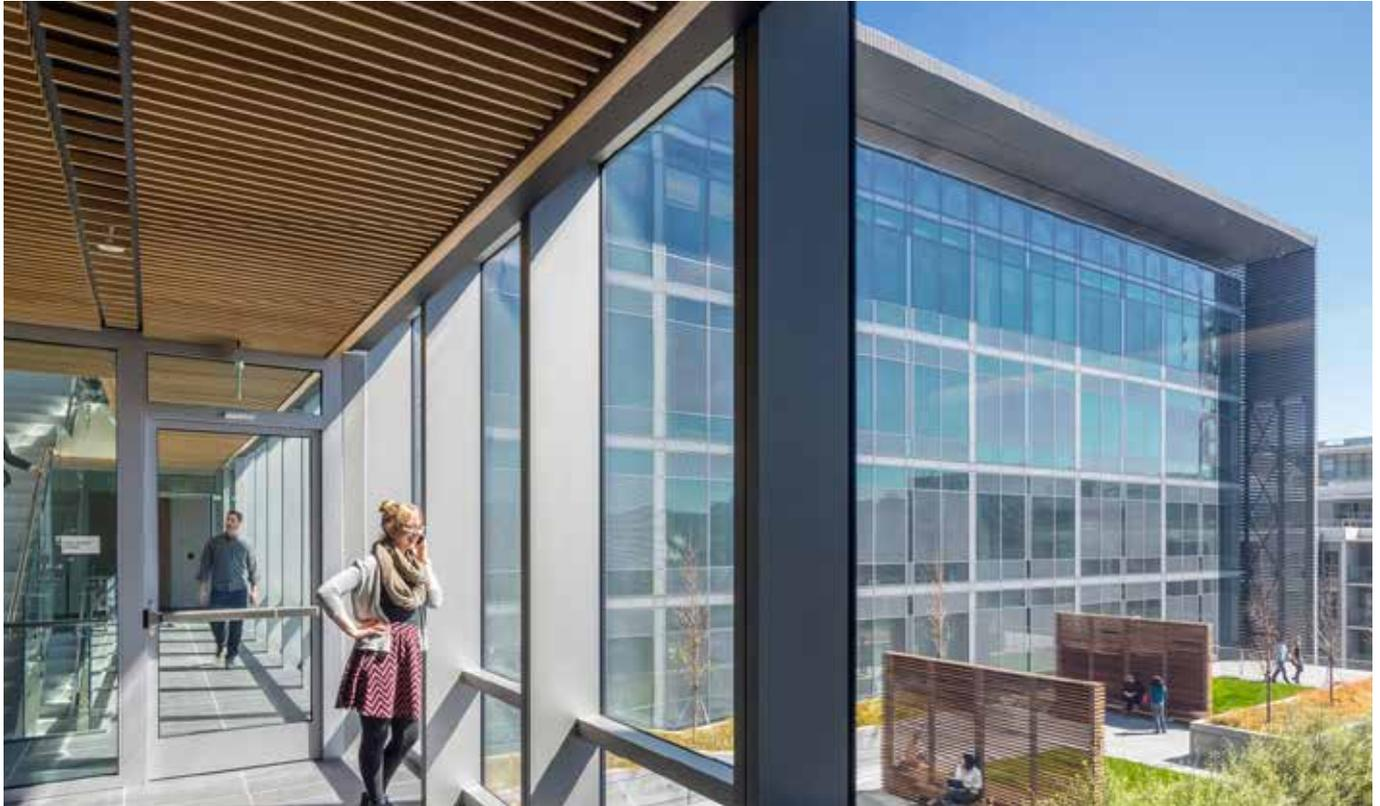
*Cuando las hojas de vidrio se laminan con un intercalario de plástico dúctil que absorbe la energía, el vidrio laminado llega a ser muy efectivo en la prevención de la penetración de impactos de bala a través del cristal, que podría causar daños a los ocupantes del edificio.*
