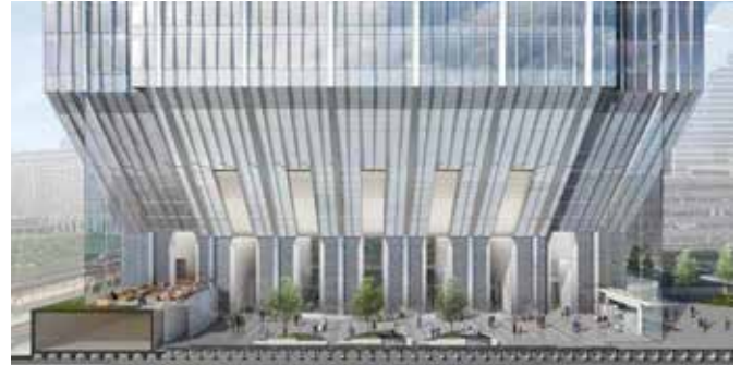
이 드라마틱한 로비는 높이가 거의 30.48m에 이르며, 자연광이 많이 들어오는 구조용 유리 핀 월 시스템으로 둘러싸여 있어서 투명도를 극대화시키는 개방된 공간을 만들어준다.
