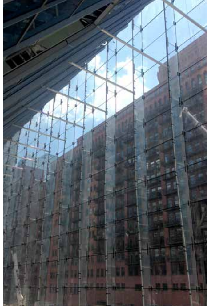
SentryGlas® 중간막이 채택된 주된 이유는 더 얇은 유리 핀의 사용을 가능하게 해준 우수한 강도와 유리 파손 후 구조유지력 및 저철분 유리를 통한 시각적 투명성 때문이었다.
