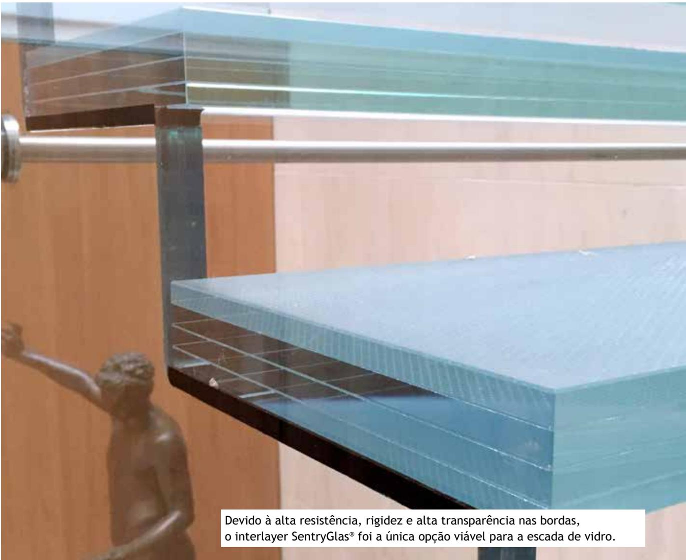
Devido à alta resistência, rigidez e alta transparência nas bordas, o interlayer SentryGlas® foi a única opção viável para a escada de vidro.
