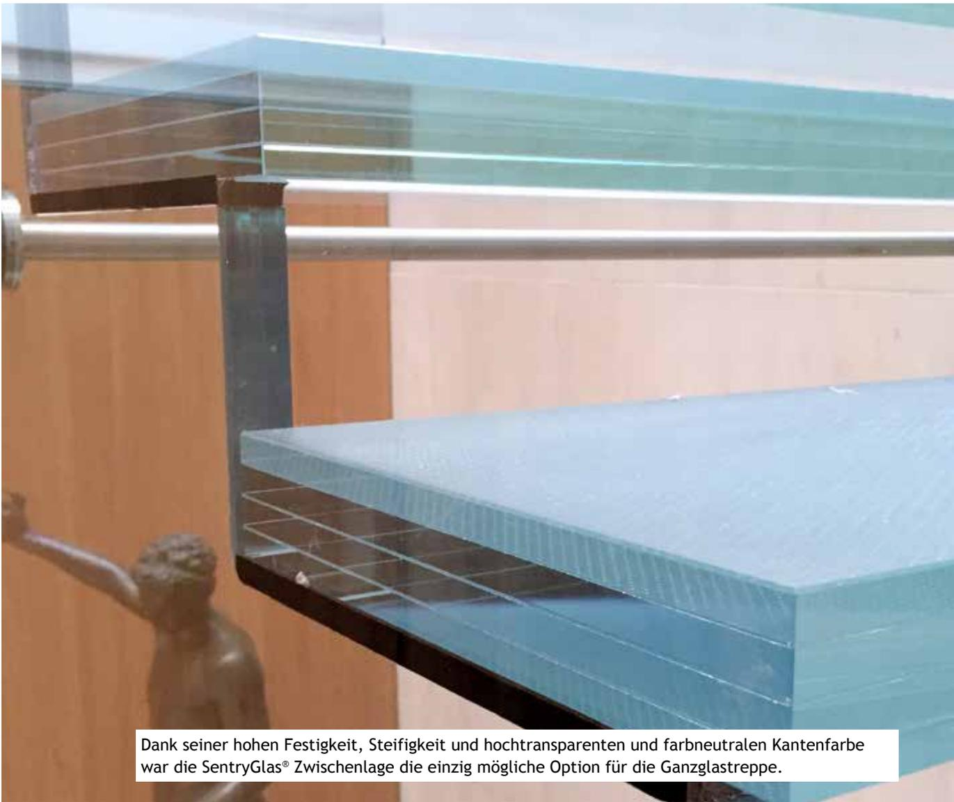
Dank seiner hohen Festigkeit, Steifigkeit und hochtransparenten und farbneutralen Kantenfarbe war die SentryGlas® Zwischenlage die einzig mögliche Option für die Ganzglastreppe.
