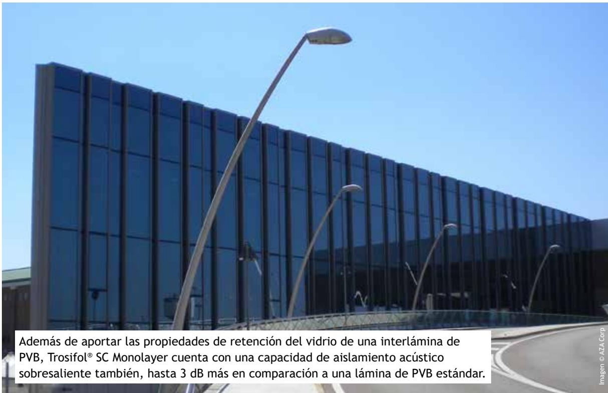
Además de aportar las propiedades de retención del vidrio de una interlámina de PVB, Trosifol® SC Monolayer cuenta con una capacidad de aislamiento acústico sobresaliente también, hasta 3 dB más en comparación a una lámina de PVB estándar.
