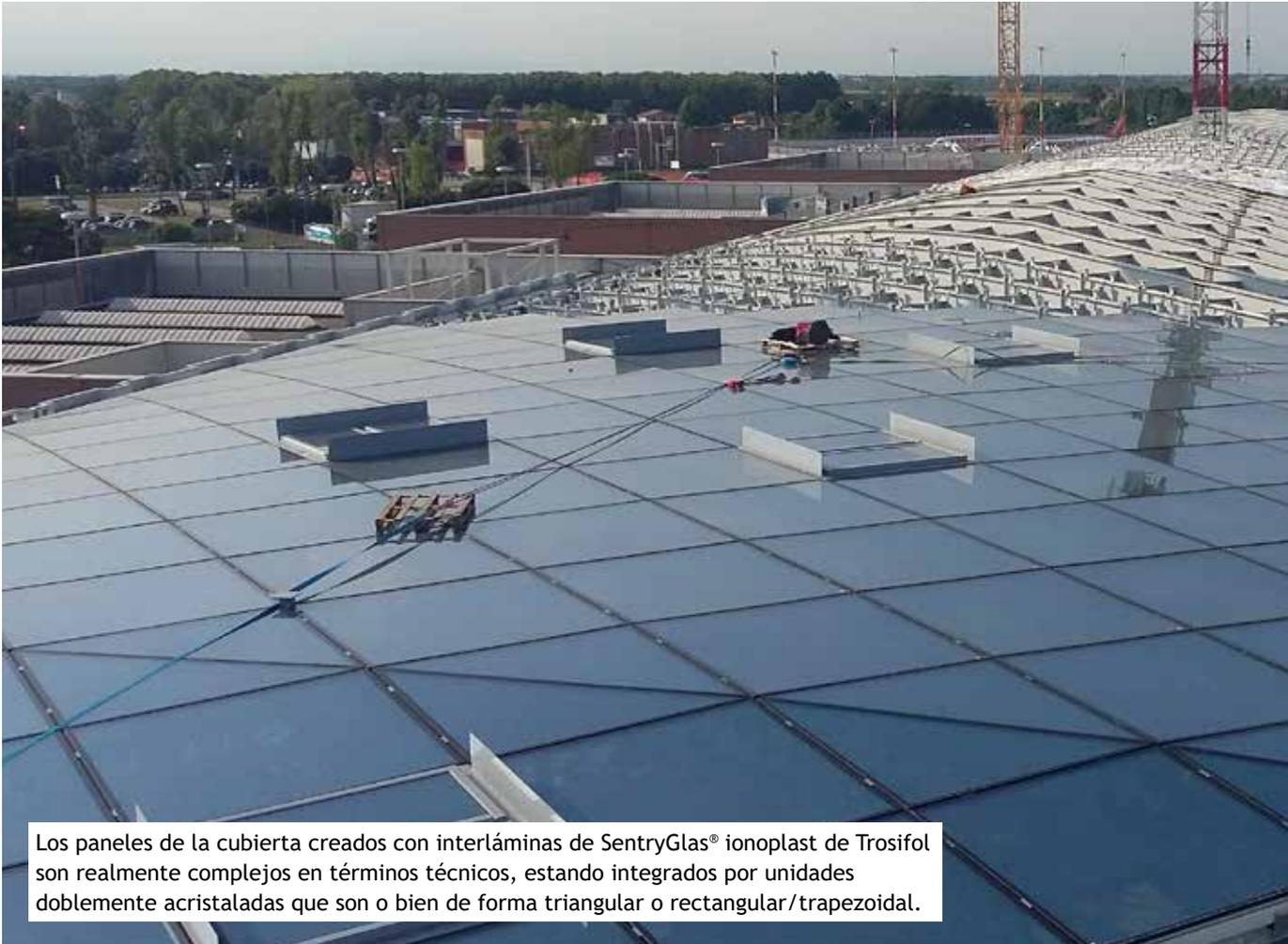
Los paneles de la cubierta creados con interláminas de SentryGlas® ionoplast de Trosifol son realmente complejos en términos técnicos, estando integrados por unidades doblemente acristaladas que son o bien de forma triangular o rectangular/trapezoidal.
