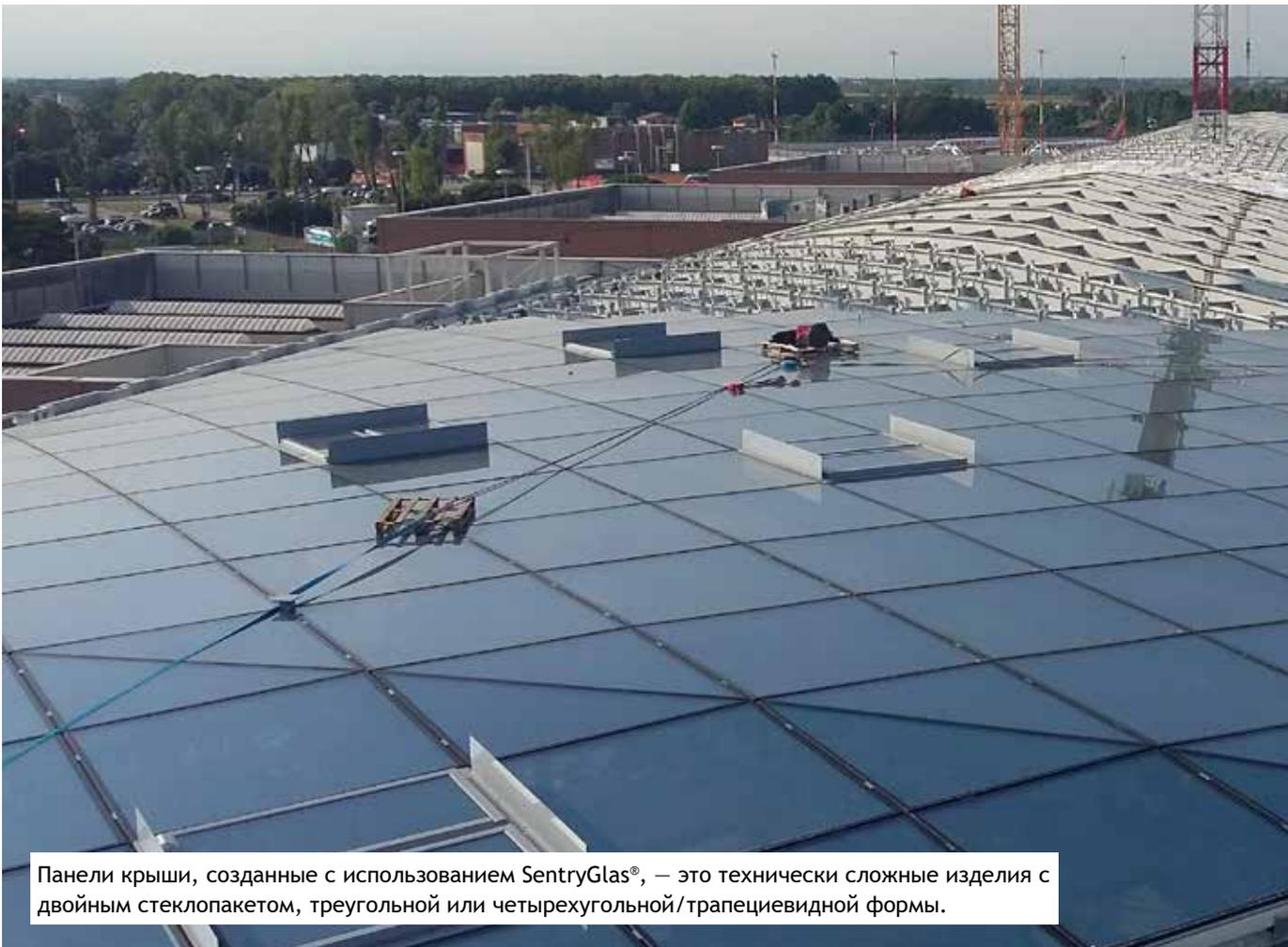
Панели крыши, созданные с использованием SentryGlas®, — это технически сложные изделия с двойным стеклопакетом, треугольной или четырехугольной/трапециевидной формы.
