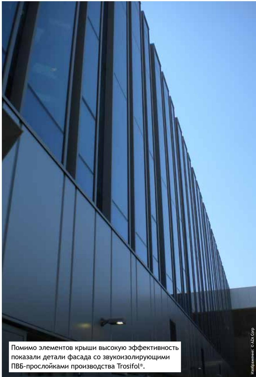
Помимо элементов крыши высокую эффективность показали детали фасада со звукоизолирующими ПВБ-прослойками производства Trosifol®.
