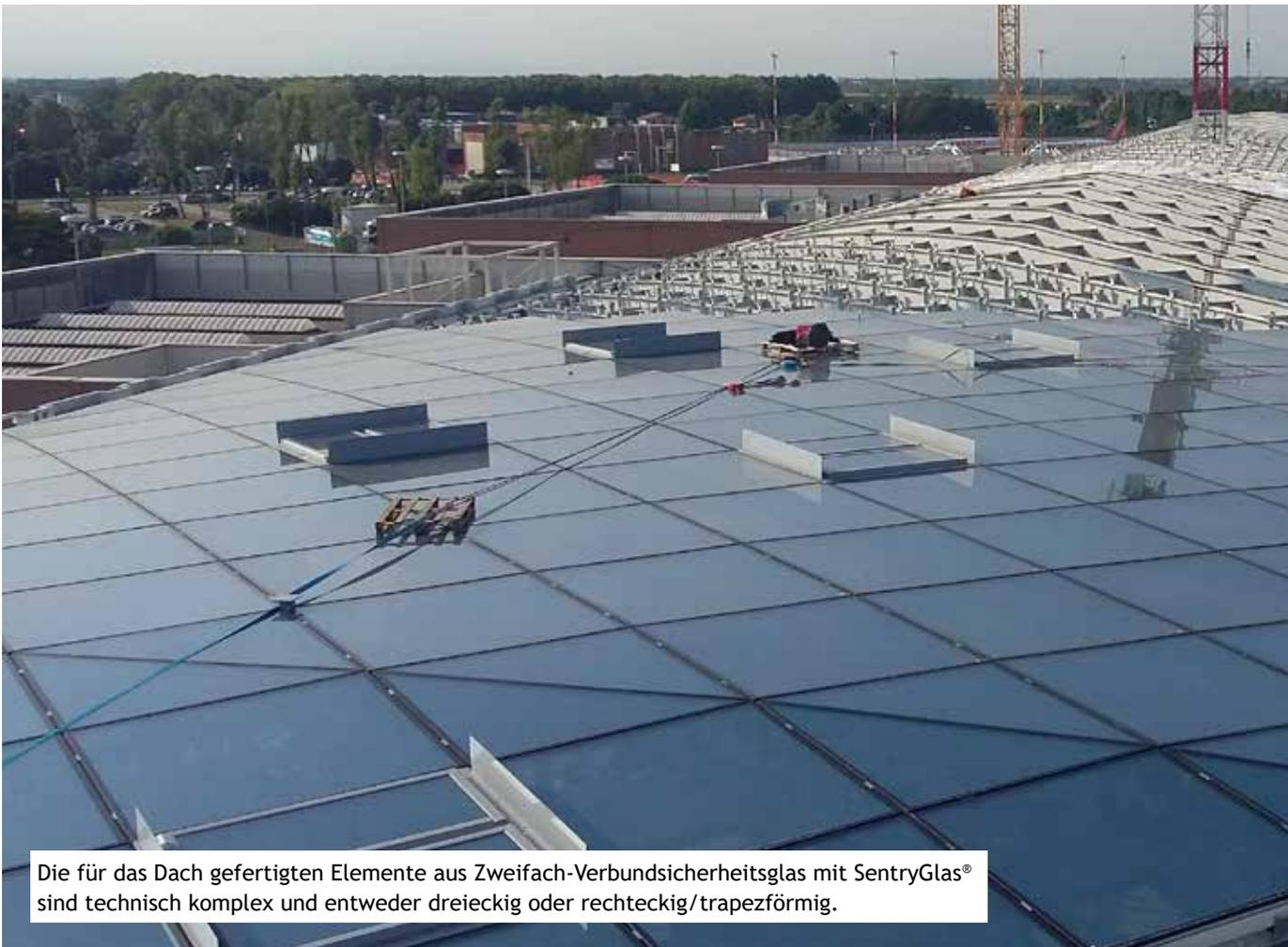
Die für das Dach gefertigten Elemente aus Zweifach-Verbundsicherheitsglas mit SentryGlas® sind technisch komplex und entweder dreieckig oder rechteckig/trapezförmig.
