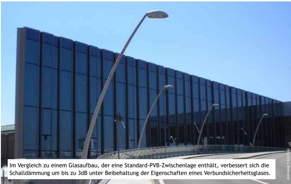
Im Vergleich zu einem Glasaufbau, der eine Standard-PVB-Zwischenlage enthält, verbessert sich die Schalldämmung um bis zu 3dB unter Beibehaltung der Eigenschaften eines Verbundsicherheitsglases.
