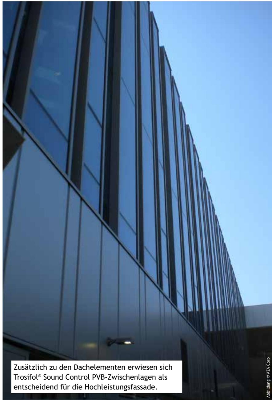
Zusätzlich zu den Dachelementen erwiesen sich Trosifol® Sound Control PVB-Zwischenlagen als entscheidend für die Hochleistungsfassade.
