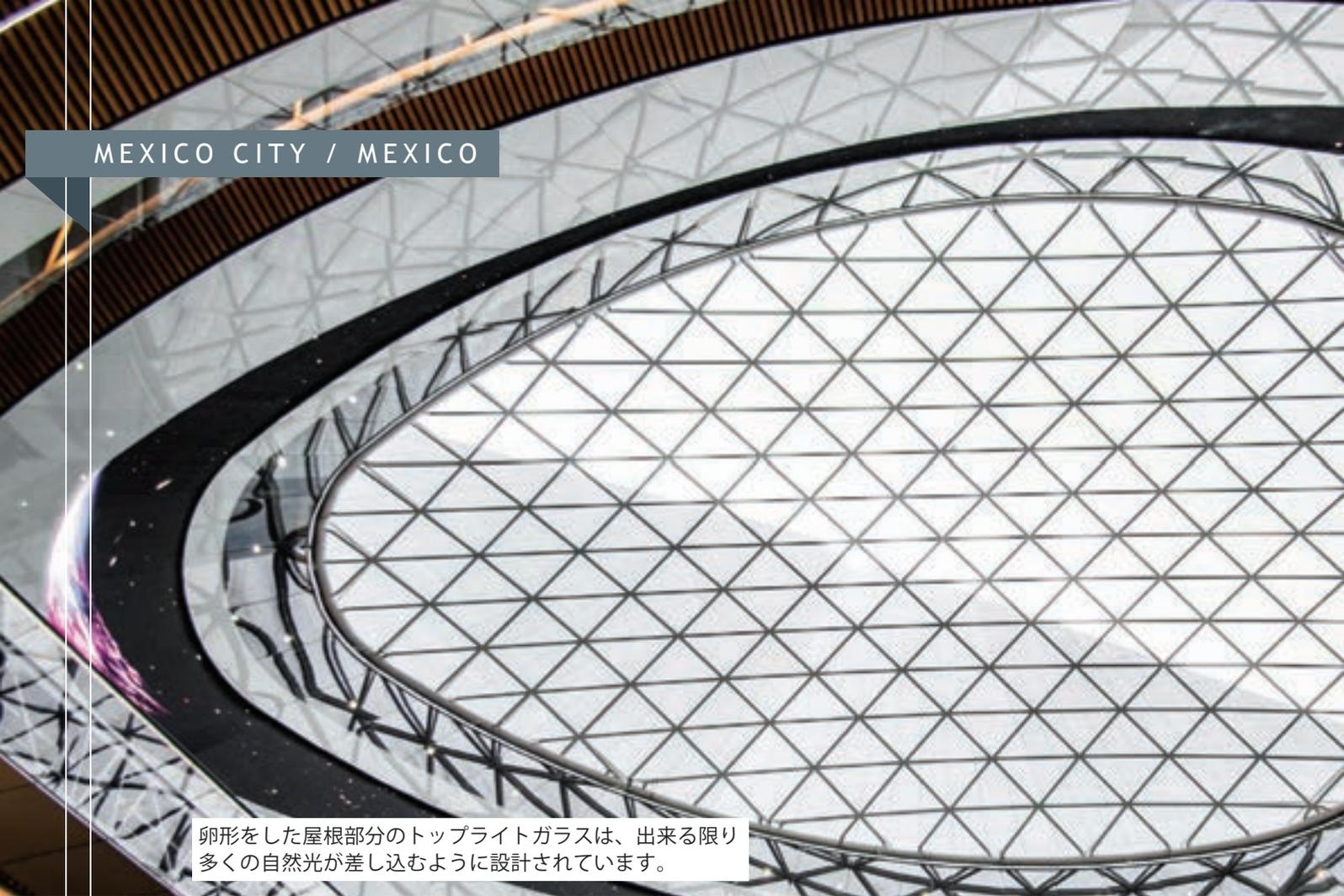
卵形をした屋根部分のトップライトガラスは、出来る限り多くの自然光が差し込むように設計されています。
