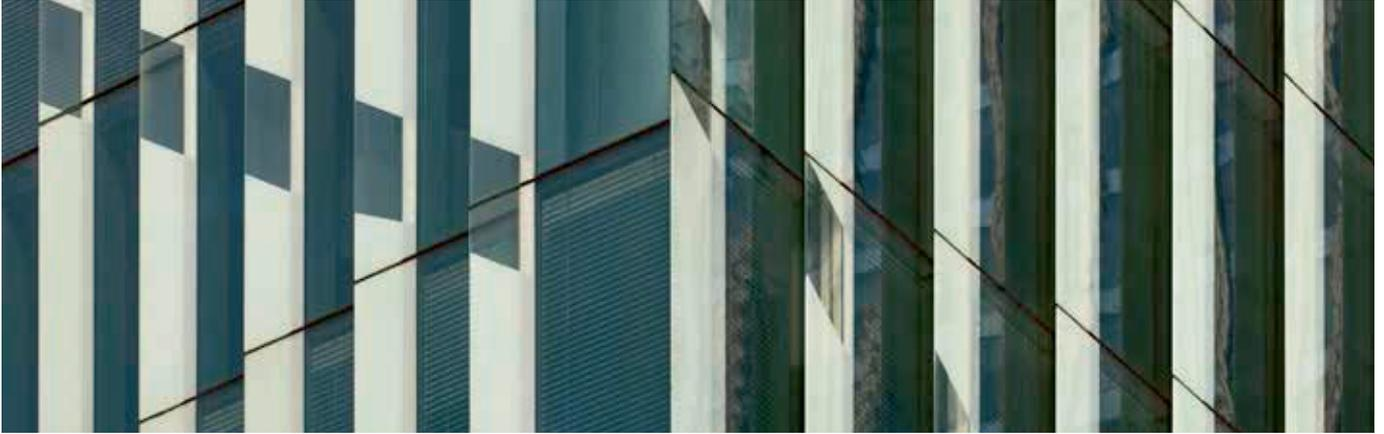
設計者とコンサルタントは、PVBを使用したガラスパネルのデザインも検討していましたが、耐候性とセラミック材料との接着性の点で採用は見送られました。
