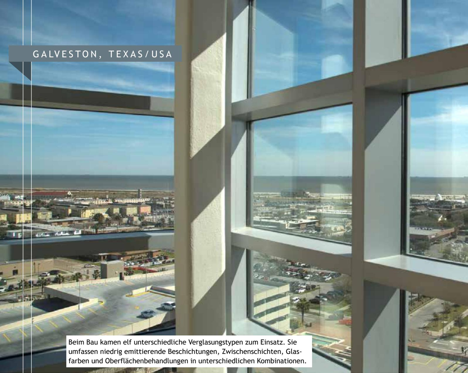
Beim Bau kamen elf unterschiedliche Verglasungstypen zum Einsatz. Sie umfassen niedrig emittierende Beschichtungen, Zwischenschichten, Glasfarben und Oberflächenbehandlungen in unterschiedlichen Kombinationen.
