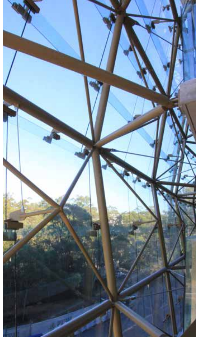
Der Einsatz von SentryGlas® Ionoplast-Zwischenlagen ermöglichte die dünnste und damit leichteste Konstruktion im Verbund mit teilweise vorgespanntem Glas.
