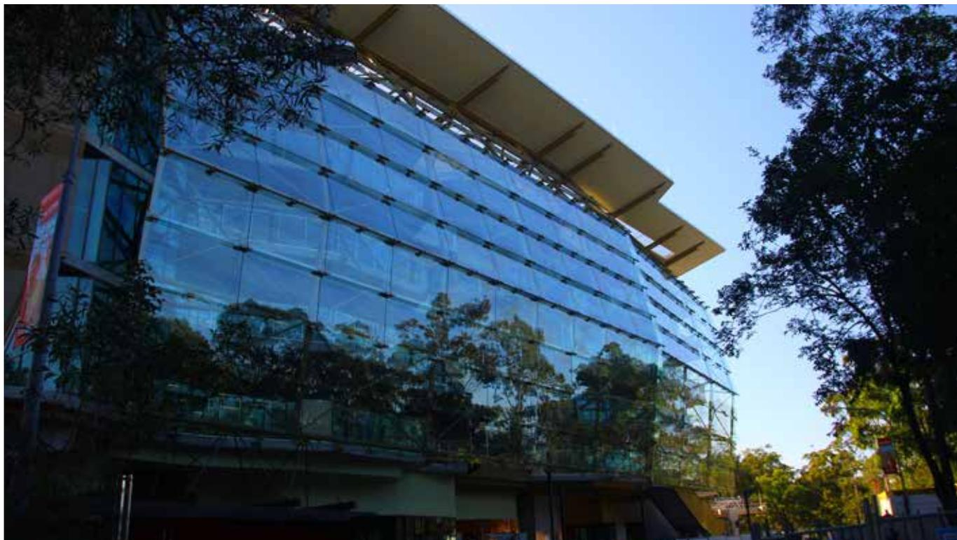
*La cara sur del edificio sur con una fachada de vidrio fachada curvada a modo de panelado que permite circulación de aire lateral y ventilación natural.*
