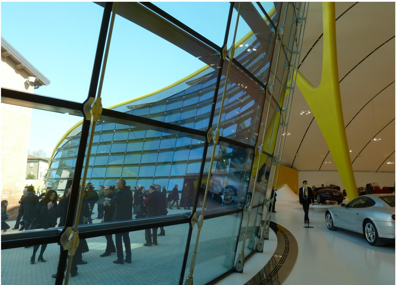
エンツォ・フェラーリ・ミュージアムのオープニング。直径32mmの鉛直のステンレス鋼製ケーブルがフラットな断熱ガラスユニットを支持しています。ガラスの構成は、外側が10mmの強化ガラス面、内側が6mm熱処理ガラス面2枚を1.52mmのセントリグラス®で合わせています。
