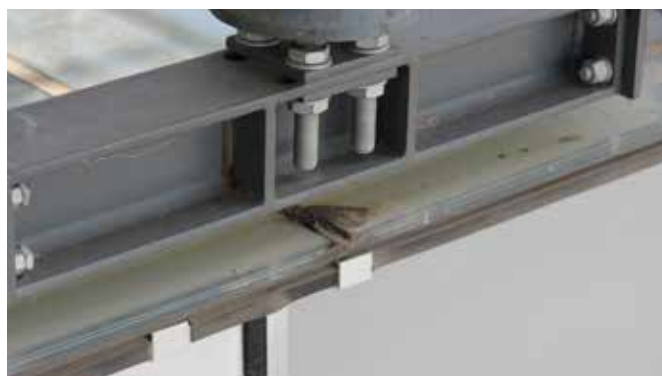
Stan paneli jest tak dobry, że inspektor skomentował, że wyglądają nadzwyczaj podobnie i mają parametry bardzo zbliżone do nowszych, niedawno zainstalowanych paneli z laminatu szklanego.
