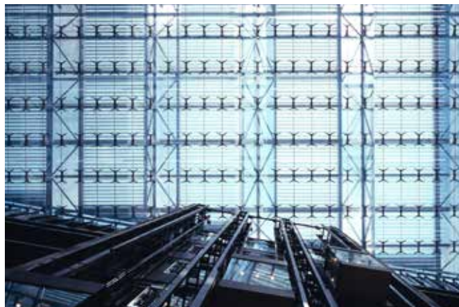
Panele mają różne kształty i wymiary. Zawierają dwie warstwy wygrzewanego i hartowanego szkła sodowo-wapniowo-krzemianowego po 8 mm oraz przekładkę o grubości 2,28 mm z materiału Sentryglas®.
