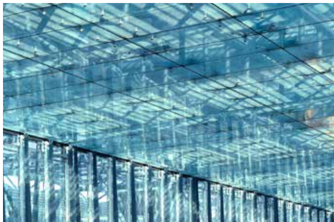
Dach o wymiarach 113 x 36 m w siedzibie firmy Endesa: niemal pozioma powierzchnia złożona z 861 przymocowanych punktowo paneli z laminatu szklanego. Łączna powierzchnia: 3.150 m 2 .
