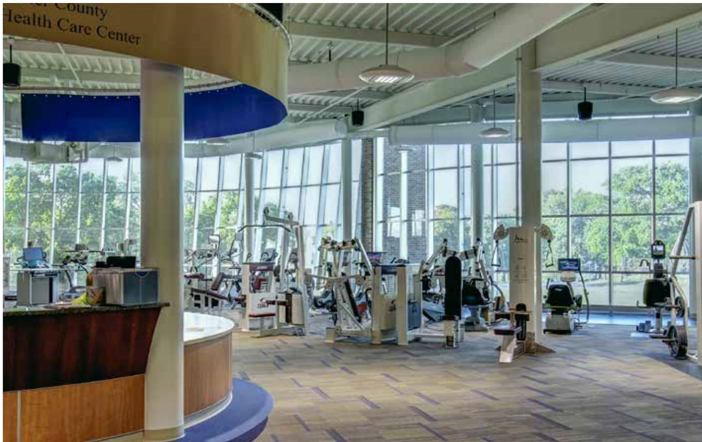
*Die vorgehängte Fassade, in der elektrochromes SageGlass® mit SentryGlas® Ionoplast-Zwischenlagen kombiniert ist, reguliert die direkte Sonneneinstrahlung und Erwärmung ohne dabei die Helligkeit im Innenraum zu beeinflussen.*
