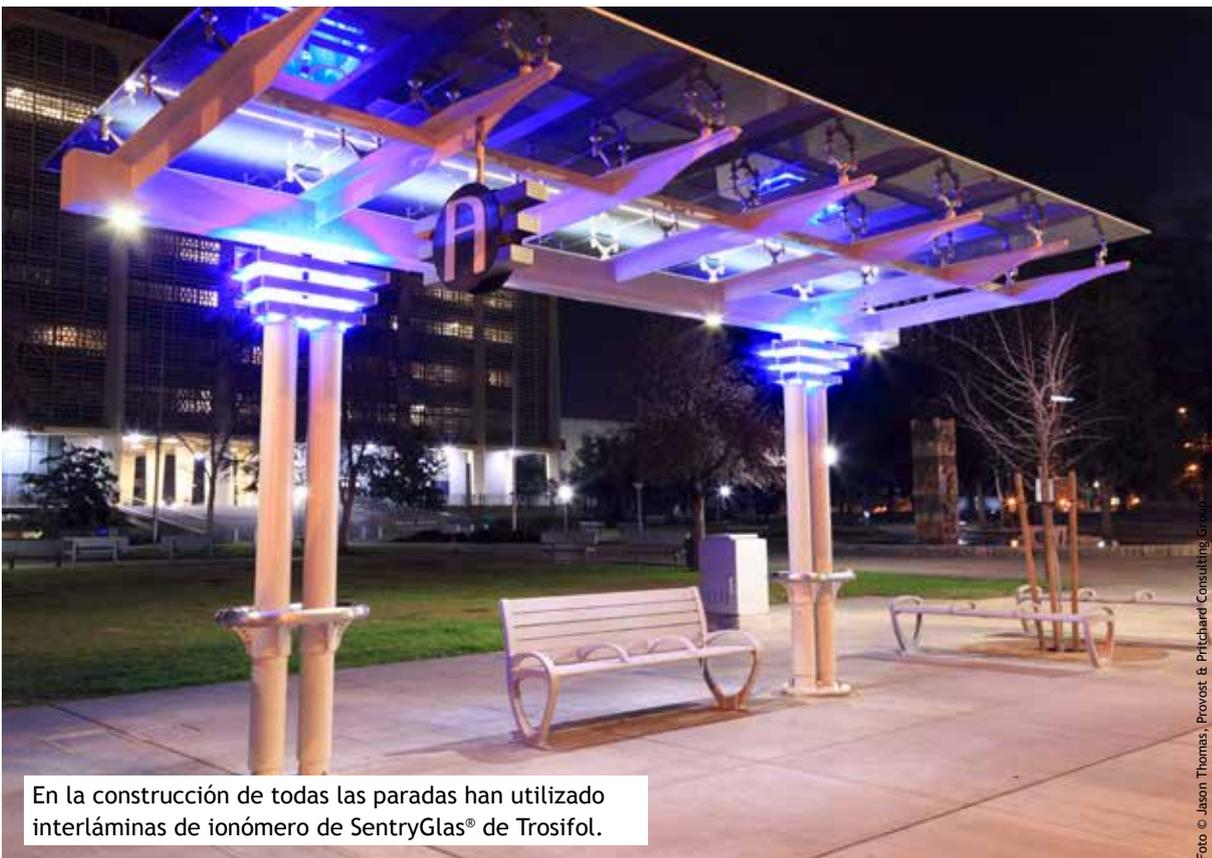
En la construcción de todas las paradas han utilizado interláminas de ionómero de SentryGlas® de Trosifol.
