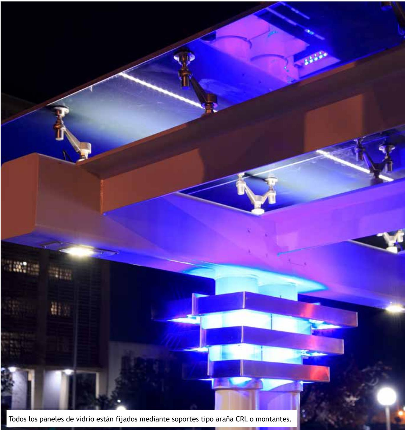
Todos los paneles de vidrio están fijados mediante soportes tipo araña CRL o montantes.
