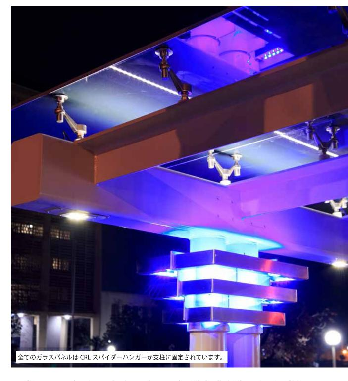
フレズノ・エリア・エクスプレスのブライアン・バー副局長は次のように述べています。「パネルと中間膜の2種類の組み合わせ――透明中間膜と青色ガラス、白の中間膜と透明ガラス――は透過光の量を減らす必要から選ばれており、結果として乗客の方々によりよい日陰を提供できています。私たちは他の選択肢も検討しましたが、ガラス屋根に初期投資する方が、似たデザインのソリッドポリカーボネート屋根よりもコスト効率が高いことがわかりました。私たちのエンジニアリングチームは、優れた強度特性を買って中間膜の使用を決めました。透明ガラス屋根の場合には陽光のコントロールにも使われています」
