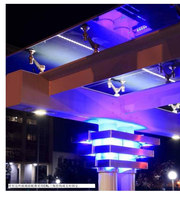
弗雷斯诺地区捷运公司副总监Brian Barr介绍到: "我们选用了两种玻璃板/中间膜组合(即透明中间膜/蓝色玻璃和白色中间膜/透明玻璃),旨在满足遮光需求,更好地为FAX的乘客提供遮蔽。此外,我们也的确进行了替代方案调查,但结果发现,初期投资应用的玻璃天篷比使用固态聚碳酸酯屋顶的类似设计更具成本效益。我们的工程团队指定使用中间膜,以满足其对强度性能的要求;而透明玻璃天篷也具有遮阳效果。"
