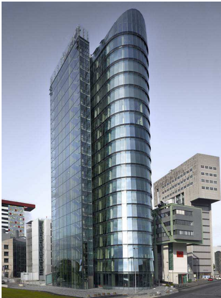
2. Tejas de vidrio en la fachada del edificio de Düsseldorf, con placas horizontales para crear una cavidad que lleva el aire al interior del edificio.
