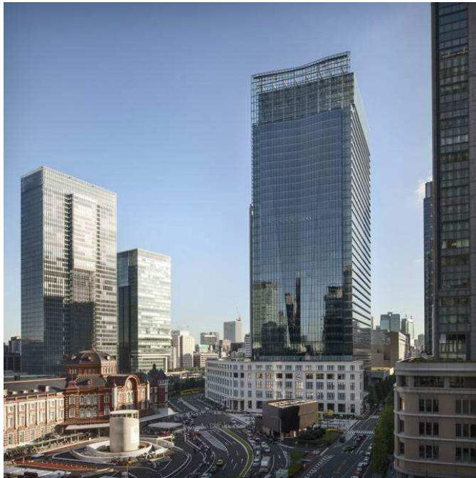
4. El edificio Japan Post
