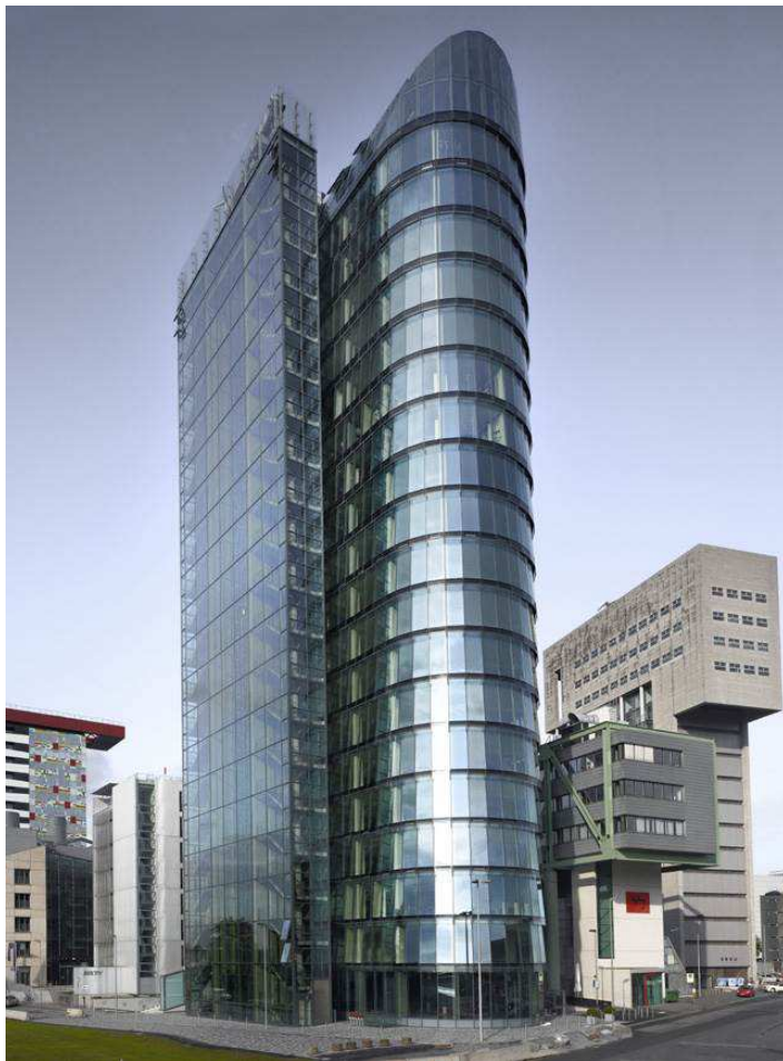
2. 뒤셀도르프(Düsseldorf)에서의 싱글 작업. 건물 안으로 공기를 유입시킬 공기층을 만들어내기 위해서 수평 싱글 사용.
