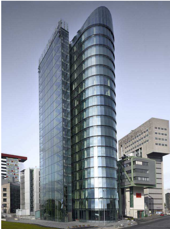
2. Budynek w Düsseldorfie: poziome gonty tworzą wnękę, która zasysa powietrze do wnętrza budynku
