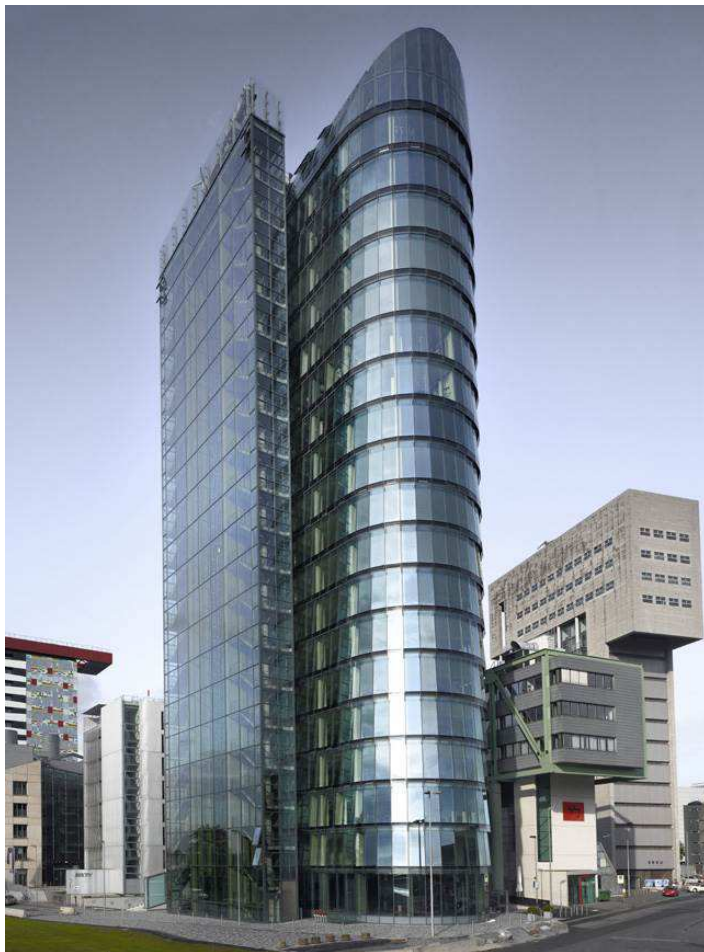
2. デュッセルドルフの建築物 ビル内に空気を引き込む空間を水平な屋根材が創り出している。
