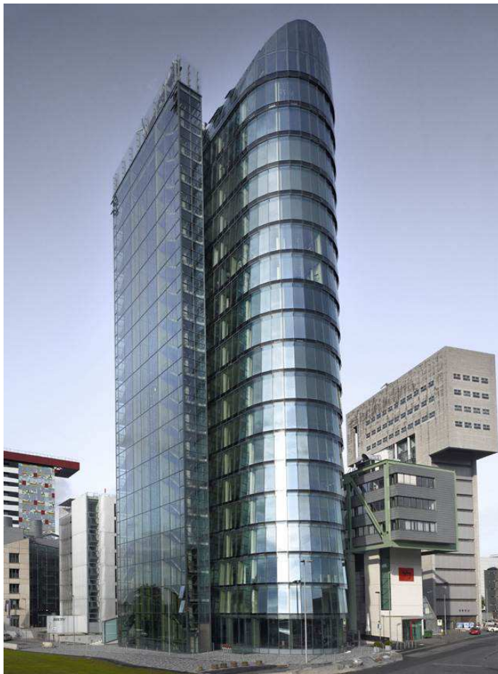
2. Die horizontal angeordnete, schindelförmige Verglasung an einem Gebäude in Düsseldorf schafft einen Hohlraum, der Luft in das Gebäude einzieht
