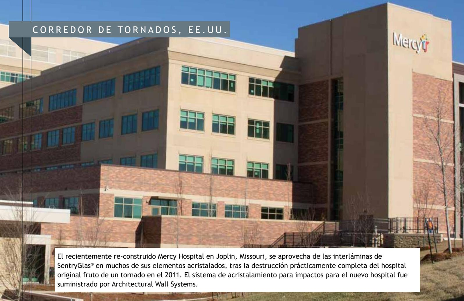
El recientemente re-construido Mercy Hospital en Joplin, Missouri, se aprovecha de las interláminas de SentryGlas® en muchos de sus elementos acristalados, tras la destrucción prácticamente completa del hospital original fruto de un tornado en el 2011. El sistema de acristalamiento para impactos para el nuevo hospital fue suministrado por Architectural Wall Systems.
