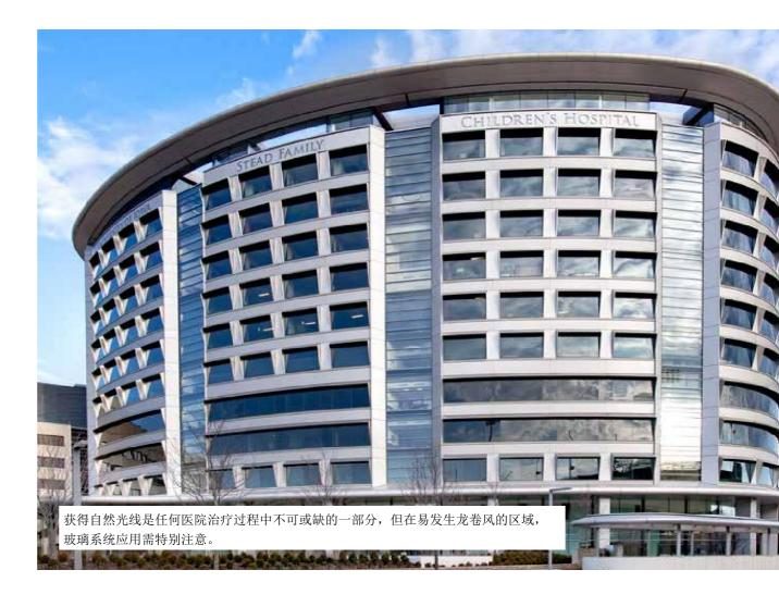
防龙卷风保护需要满足三大要求:能抵御风荷载影响的设计、合理的地基或支柱以及防碎片性能(对于玻璃结构及幕墙应用尤为重要)。对于旨在满足防龙卷风应用标准的玻璃结构,为评估其防碎片性能,应进行投射物测试。该测试的要求要远高于针对那些旨在在飓风中抵御风载碎片的玻璃系统的投射物测试。不同于须抵御以34 mph(55 km/h)速度移动的9 lb.(4.1kg)、2 x 4 in(5 x 10 cm)的飓风冲击的防飓风玻璃系统,防龙卷风玻璃系统必须能经受以100 mph(160 km/h)速度移动的15 lb.、2 x 4 in龙卷风的冲击。
