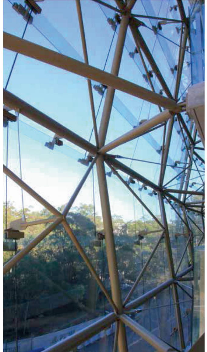
セントリグラス® アイオノマー樹脂製中間膜を使用すれば、熱強化した合わせガラスを使用したこのファサードスクリーンで、最も薄く、したがって最も軽い設計が実現できます。
